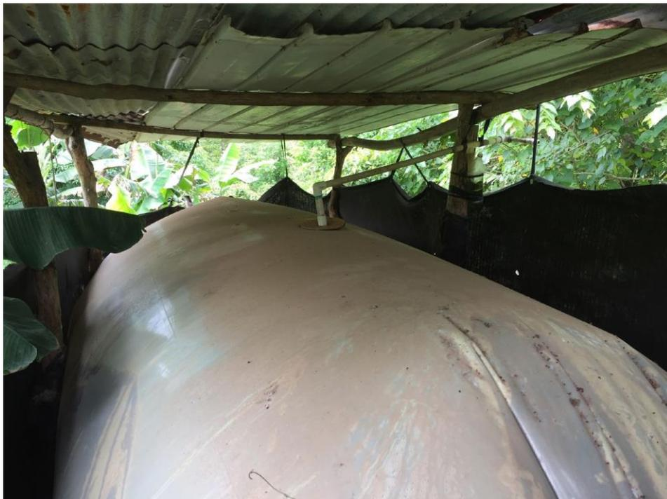
■ Sistema de biodigestor alimentado con los excrementos de puercos
