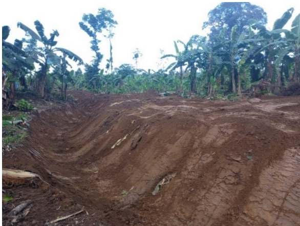
Ilustración 83: Drenajes realizados con pala mecánica en una finca de plátano del distrito de Chiriquí Grande (Ramirez, N., 2022)
