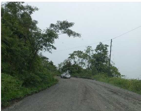
Ilustración 20: Tramo en construcción de la carretera Gualaca – Chiriquí Grande (Ramírez N., 2022)
