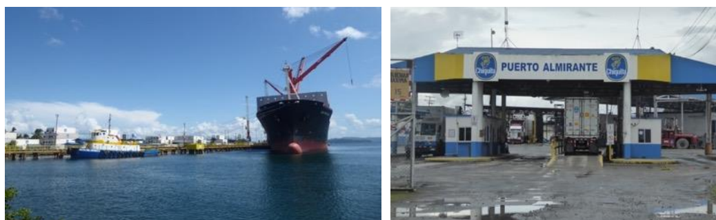
Ilustración 8 – Fotografías de las instalaciones portuarias de la ciudad de Almirante
